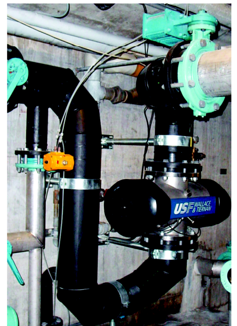
Abbildung 3: Eingebaute UV-Anlage
